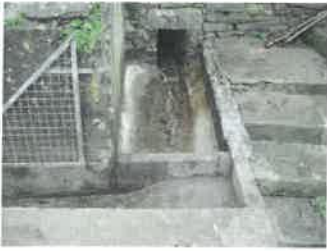
Vue de l'ouvrage génie-civil
