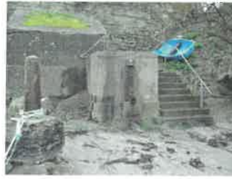
Arrivée d'eau dans la bêche
